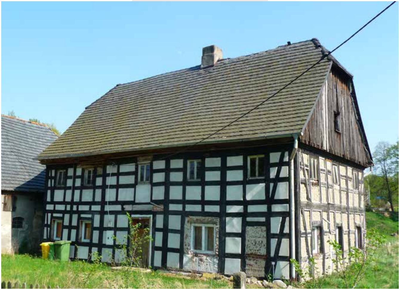
166. Dom w konstrukcji szkieletowej wieś Golnice, pow. Bolesławiec
